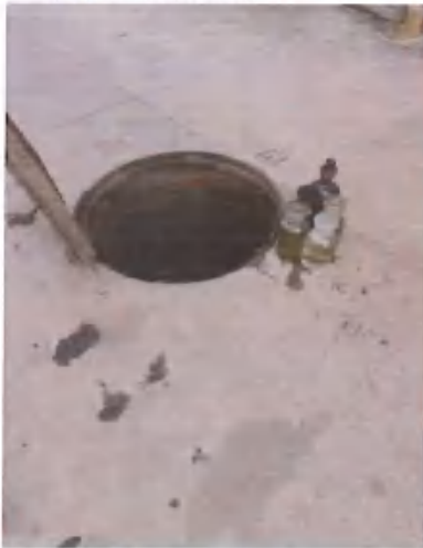
生活污水排放口
